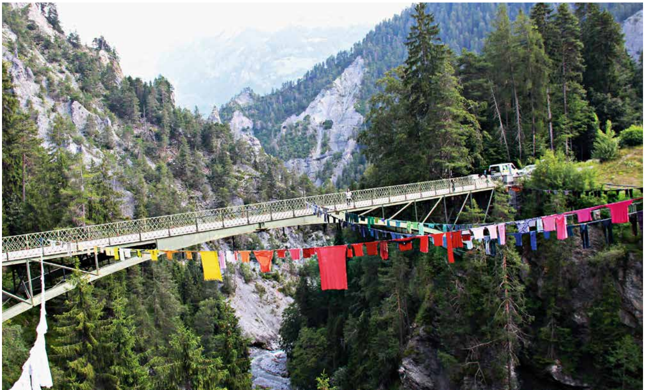
Die Künstlerin Jaffa Lam aus Hongkong hat zwischen der alten und der neuen Versamertobel-Brücke über die malerische Versamer Schlucht mit der Rabiusa Hunderte von Altkleidern aufgehängt.
