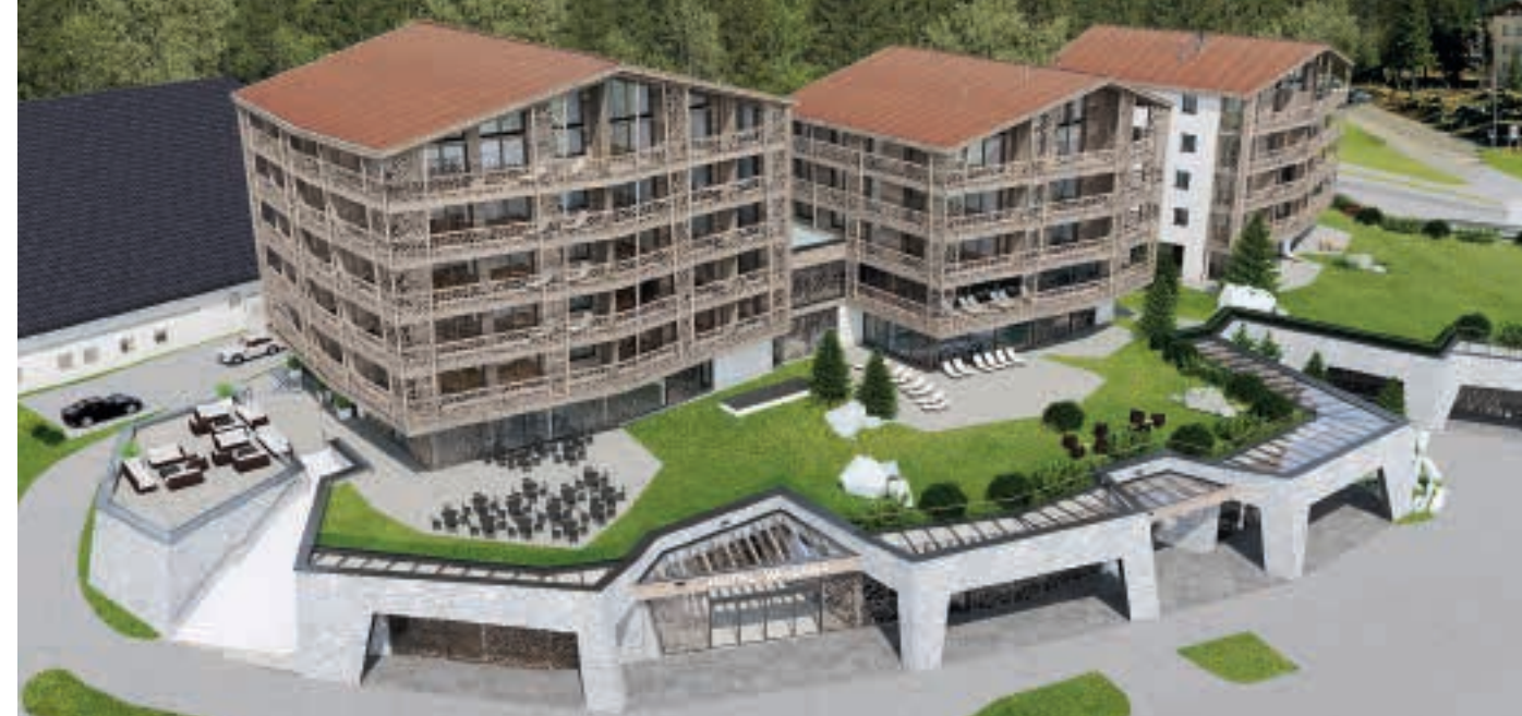
«Valsana Hotel & Appartements» in Arosa. (Bild: Valsana Hotel & Appartements)
