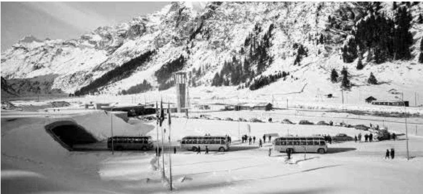
Der San Bernardino-Strassentunnel. (Bild: ETH Zürich)
